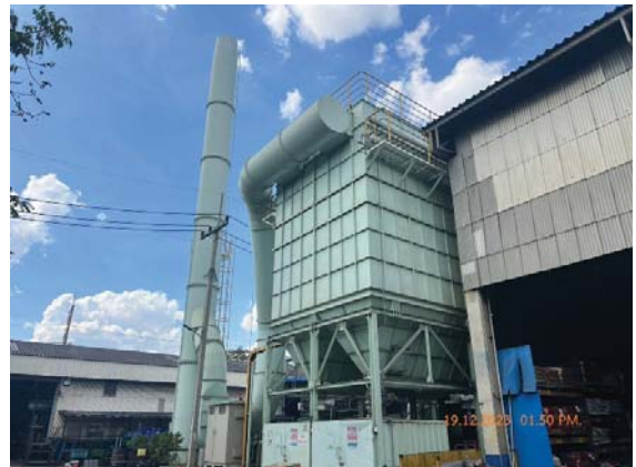
ภาพที่ 10 ปล่องระบบดักฝุ่นจาก Melting furnace No.3&4 (Line AMF)
